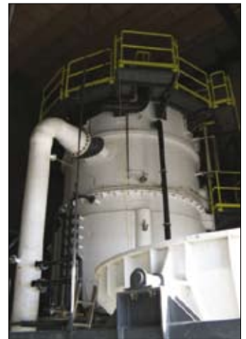
Blick in das Innere des Produktionsturms (Foto: Pitztaler Gletscherbahn)
