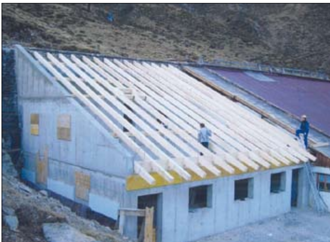
Beim Wiederaufbau der Hütte.
