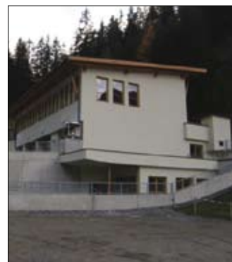
Zubau mit Eingang zum Probelokal.
