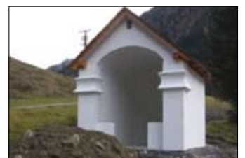
Die neu errichtete Wegkapelle an der Pitztaler Landesstraße.
